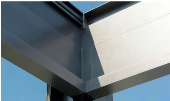
Wasserablauf in der Stütze
